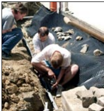
Pan Zika s týmem spolupracovníků odstranil havárii ve svodu dešťových vod při "Lurdské kapli". Voda zatékala do základů a promáčela zádivo.
